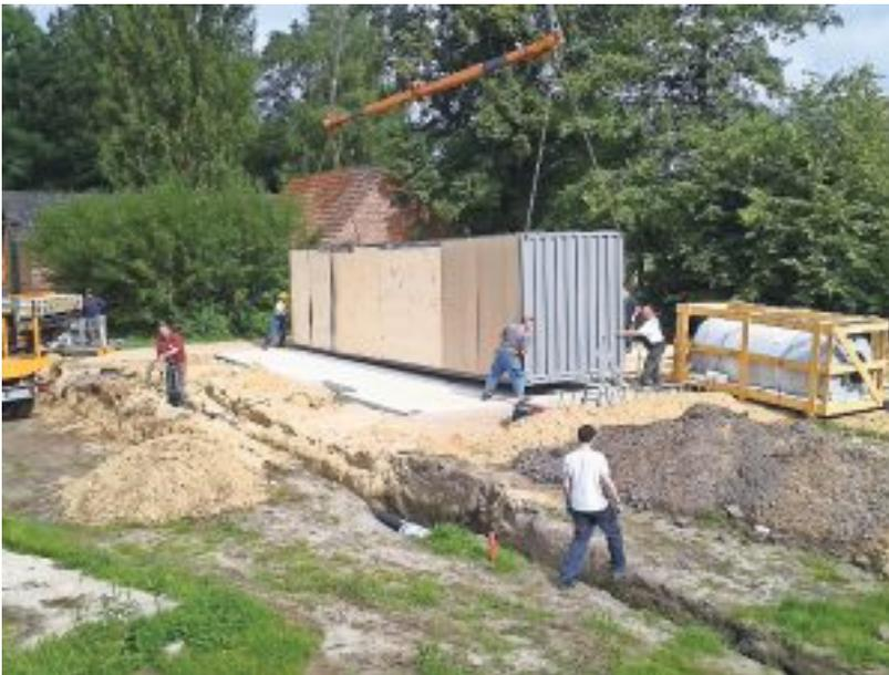
Mit dem Aufstellen einer Container-Heizzentrale ist der wichtigste Schritt zur Fertigstellung der Wärmeversorgung getan.
